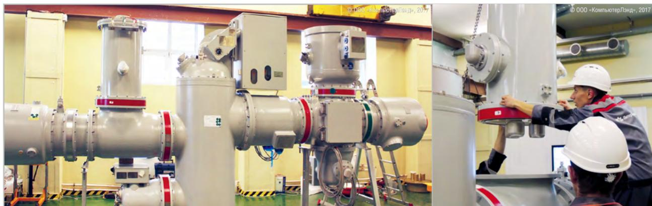
Одним из основных достоинств КРУЭ является их высокая надежность, обеспечиваемая высокими изоляционными и дугогасительными свойствами элегаза и сведением к минимуму неблагоприятных атмосферных воздействий.
