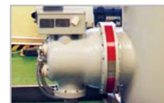
В КРУЭ применяется трехпозиционный модуль с разъединителем и заземлителем, обеспечивающий простоту конструкции и надежную механическую блокировку.
