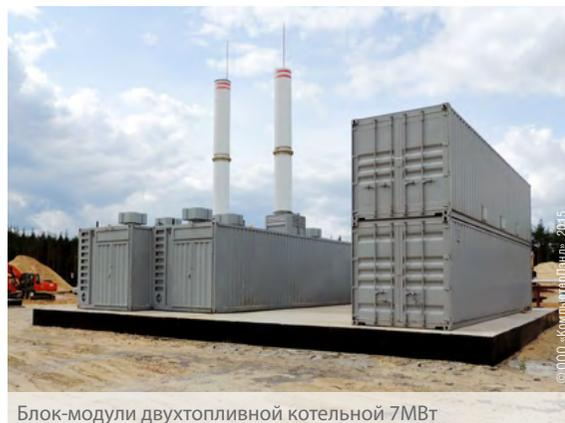
Блок-модули двухтопливной котельной 7МВт
