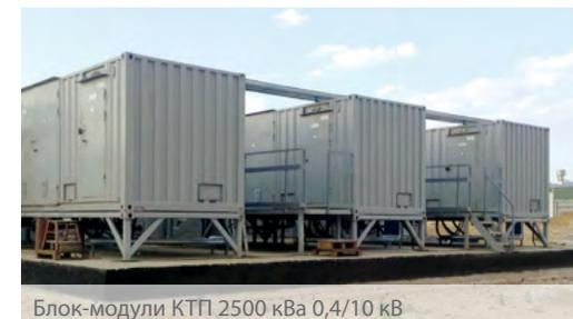
Блок-модули КТП 2500 кВа 0,4/10 кВ
