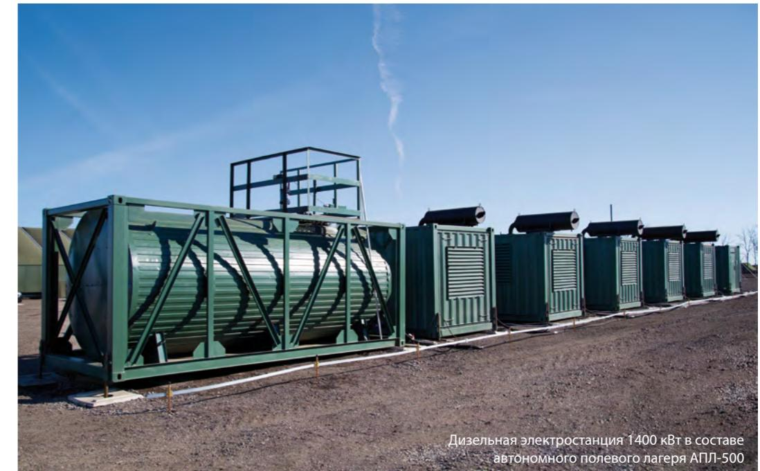
Дизельная электростанция 1400 кВт в составе автономного полевого лагеря АПЛ-500
