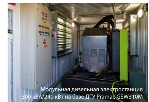
Модульная дизельная электростанция 300 кВА/240 кВт на базе ДГУ Pramac GSW310M
