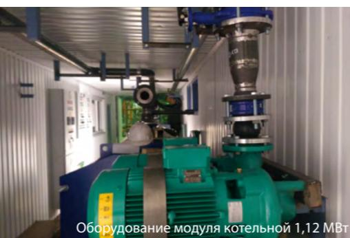
Оборудование модуля котельной 1,12 МВт
