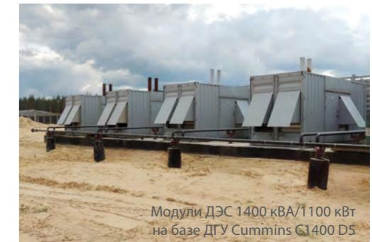
Модули ДЭС 1400 кВА/1100 кВт на базе ДГУ Cummins C1400 D5
