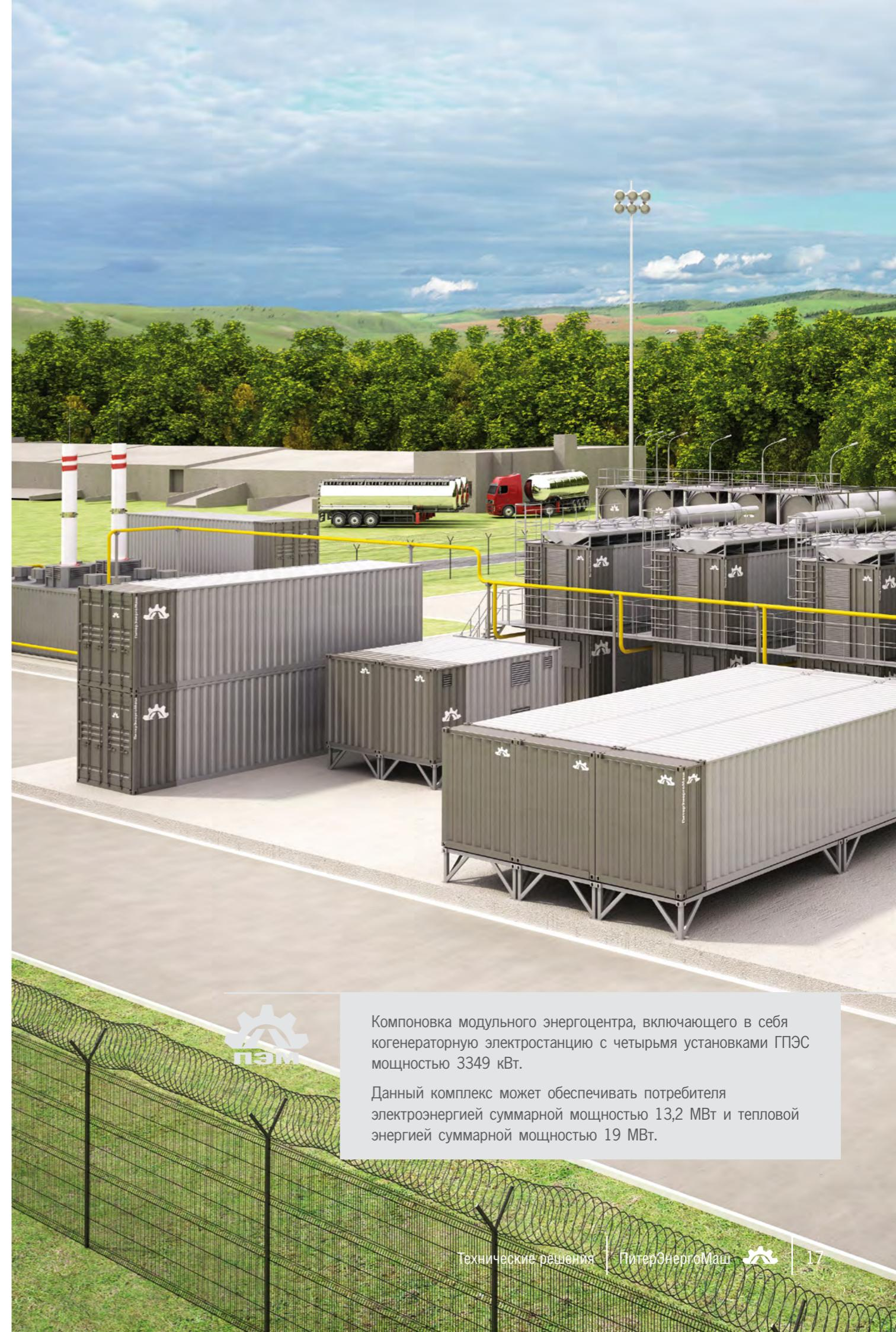
Компоновка модульного энергоцентра, включающего в себя когенераторную электростанцию с четырьмя установками ГПЭС мощностью 3349 кВт.
